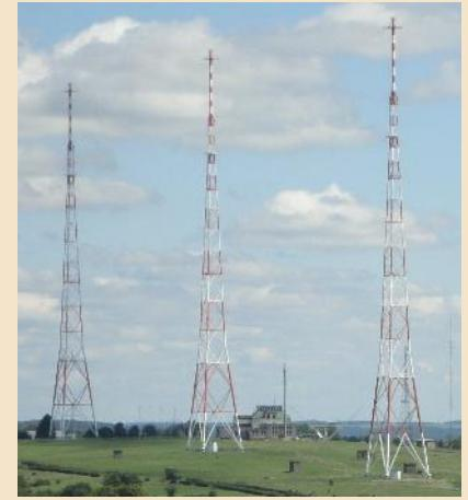
Nördlich von Junglinster befindet sich seit 1932 die große Sendeanlage für das auf Langwelle ausgestrahlte französischsprachige Programm der RTL-Group. Als Antenne kommt seit 1954 eine aus drei freistehenden, gegen Erde isolierten Sendeturmen (Selbststrahlender Sendemast) mit dreieckigem Querschnitt und einer Höhe von 215 Metern (bis 1980: 250 Meter), bestehende Richtantenne (Hauptstrahlrichtung: Südwest) zum Einsatz.
